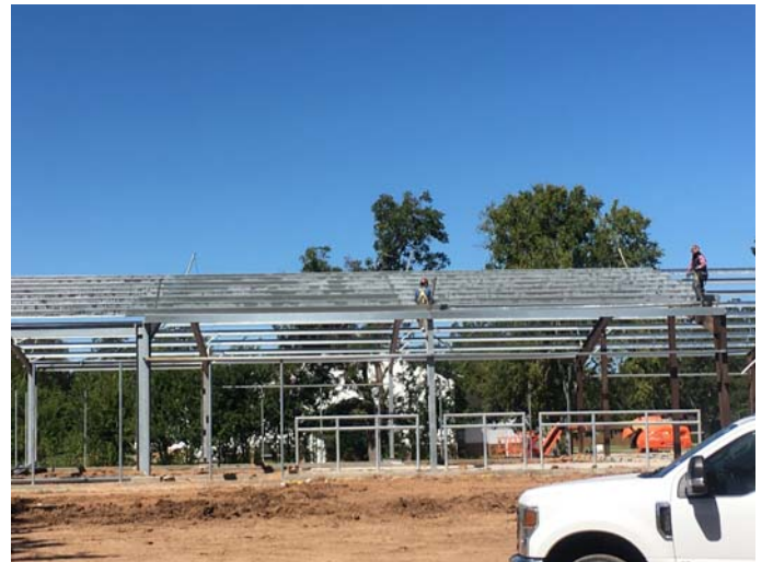
4. Erection of PEMB roof framing
