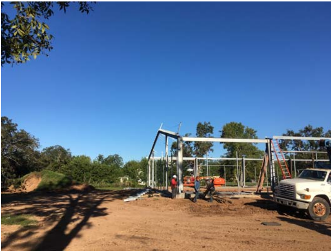
1. Erection of PEMB frame
