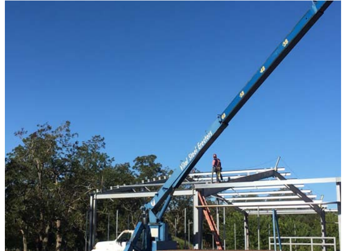
2. Erection of PEMB frame
