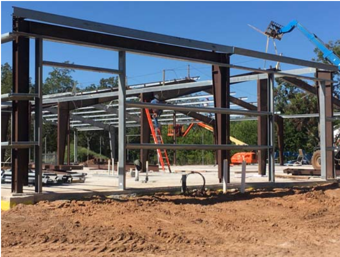
3. Erection of PEMB frame
